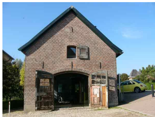
Dorpsschuur, Oosterhoutsedijk 29 Lent. Foto www.dorpsschuurlent.nl
