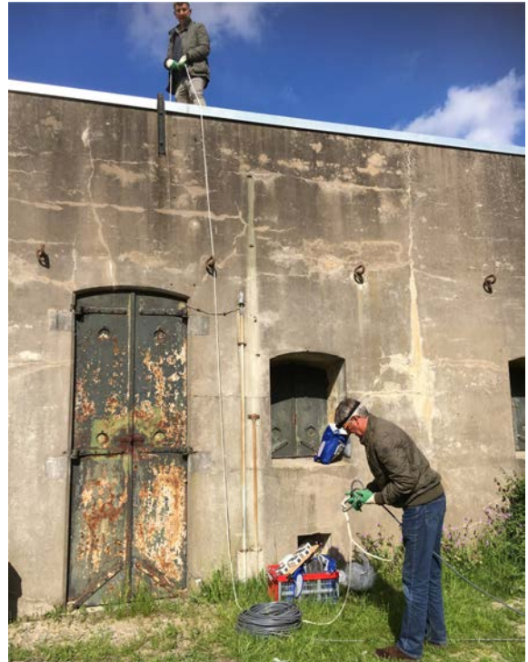
Foto: Berna van Baarsen MARC EN TON LEGGEN DE KABEL AAN
