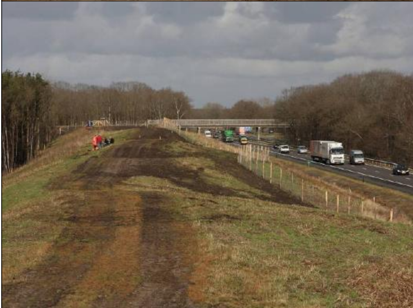
Werkzaamheden in het NP Dwingelderveld (Foto's: Albert Henckel)
