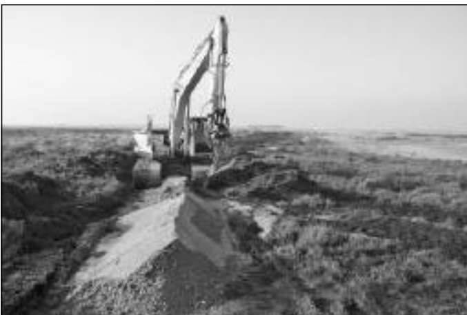
Aanleg kade in het Dwingelderveld
