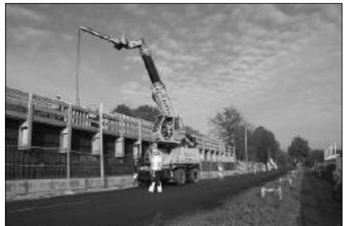
Het ecoduct over de A28
