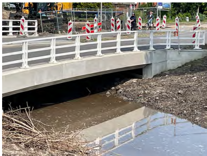
Faunapassage onder de nieuwe brug in de Meerweg
