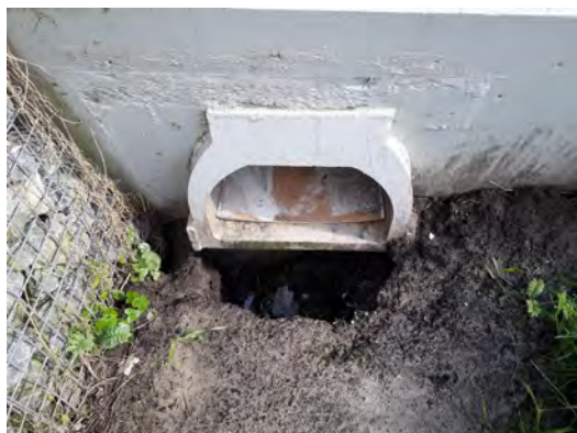
Faunapassage waar grond is weggeslagen
