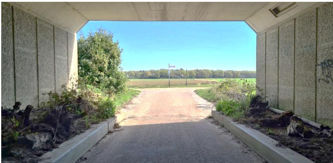
Foto 1: Stobben onder het fietsviaduct
