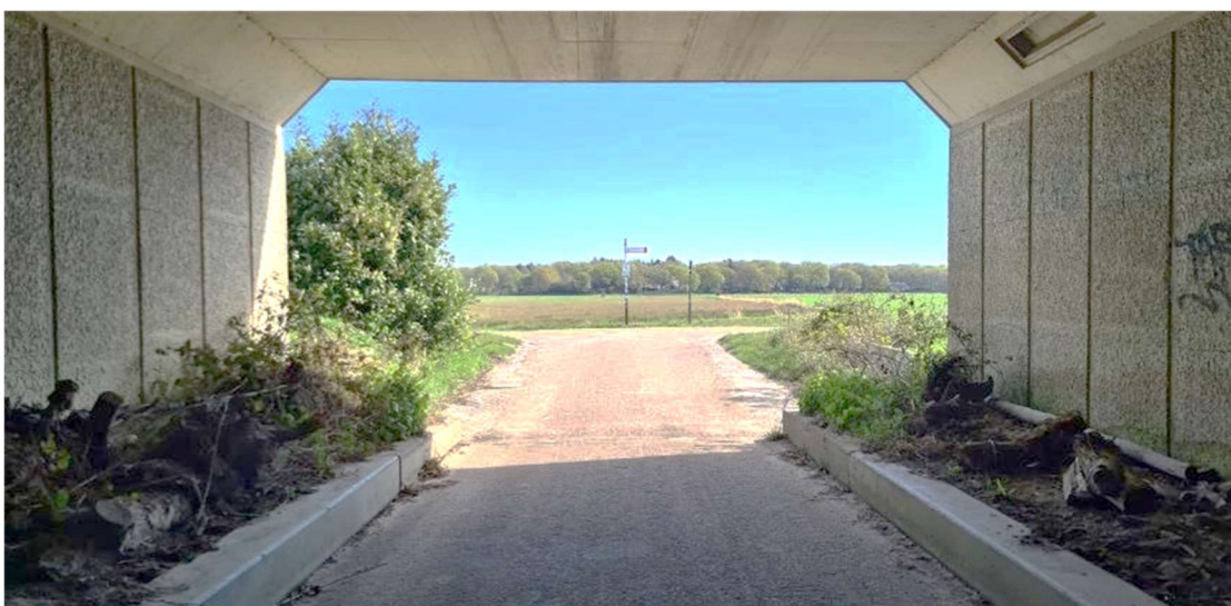
Foto 1: Stobben onder het fietsviaduct
