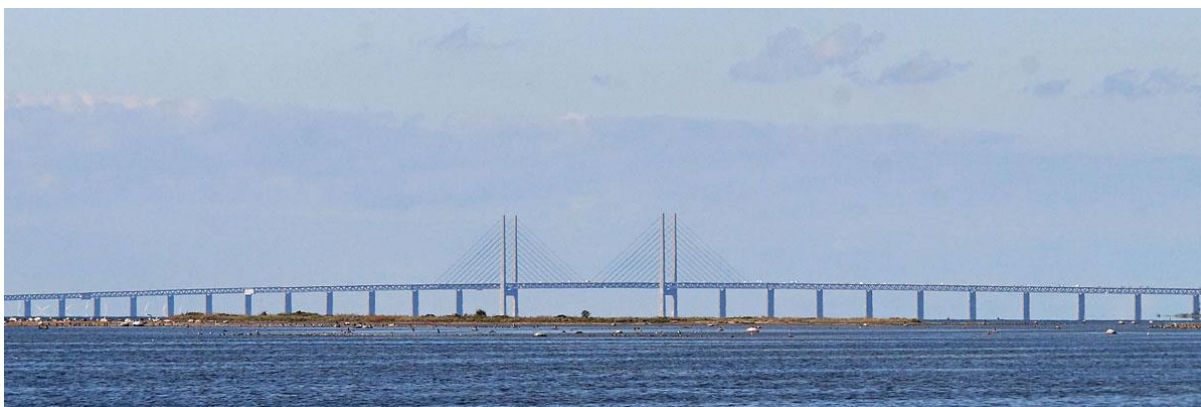
De brug over de Sont, gezien vanaf de golfbaan
