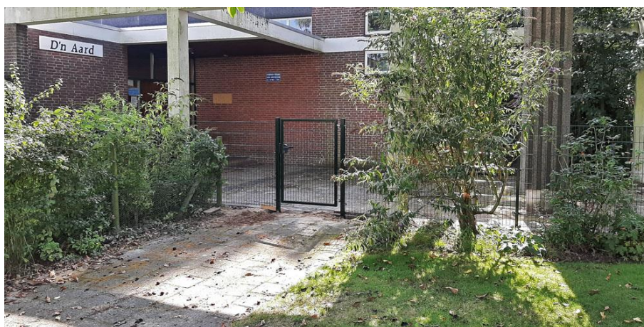
Het nieuwe hekwerk met toegangspoort.
