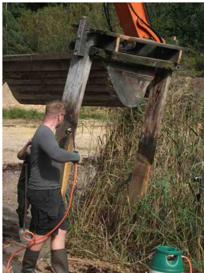
Het afbranden van de dragers van de brug.
