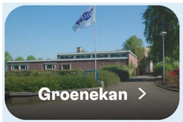
F16 Pompstation Groenekan
