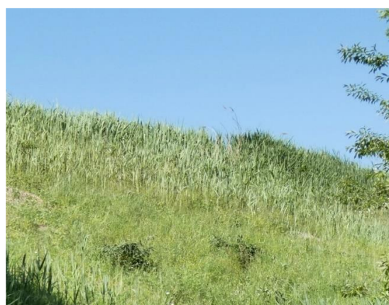
Riet in talud van A50
