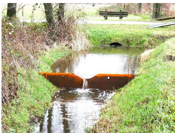
Plaatstuw in de Venloop
