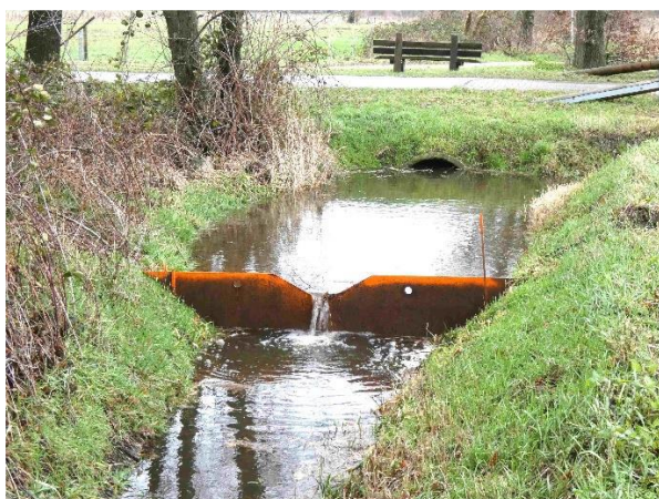
Plaatstuw in de Venloop
