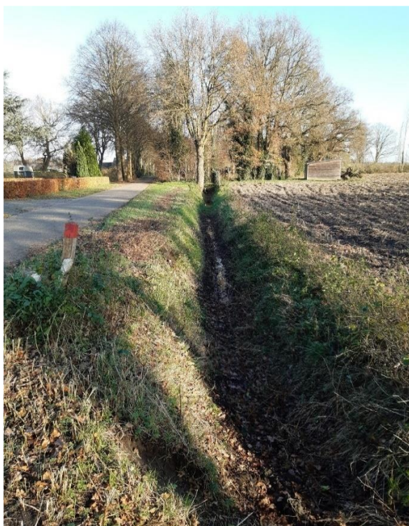
Bovenloop van De Mortelloop
