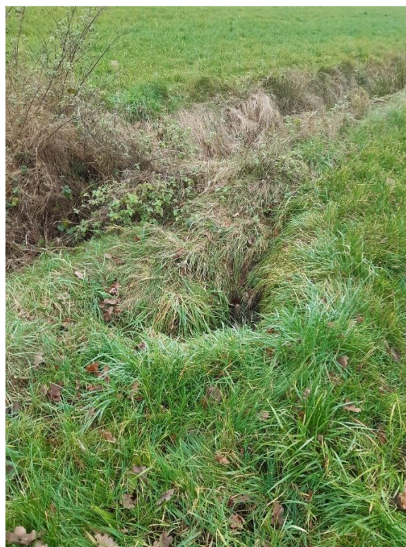
Verzakking van de slootkant door kwel
