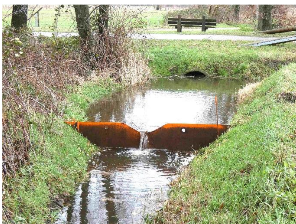
Plaatstuw in de Venloop
