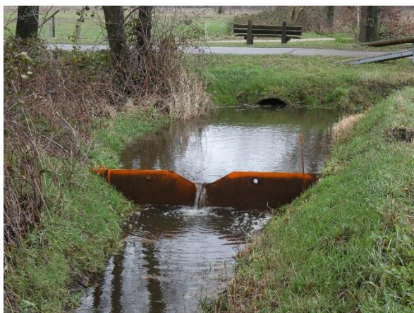
Plaatstuw in de Venloop
