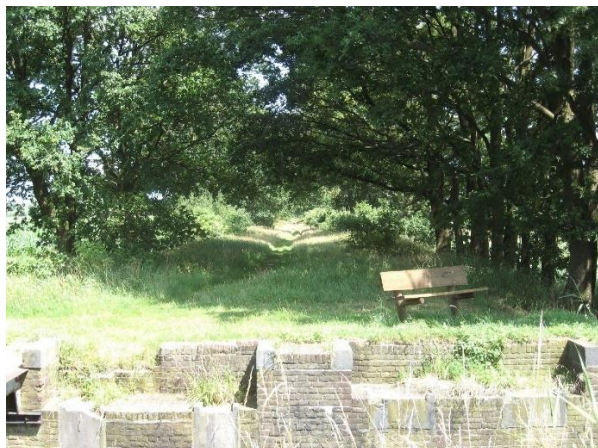
Duits lijntje vanaf de oude brugfundering over de Leijgraaf
