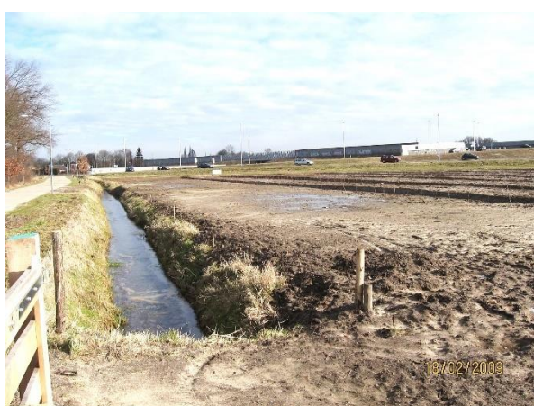
Aanleg van de stapsteen aan de Egelweg 2009
