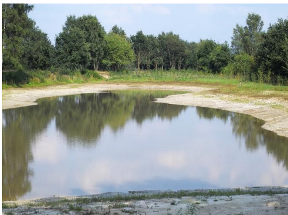
Trentse dijk na de aanleg in 2006
