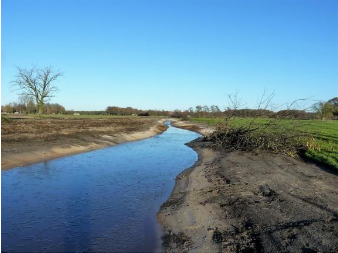
De nieuwe benedenloop vanaf de Slabroekseweg
