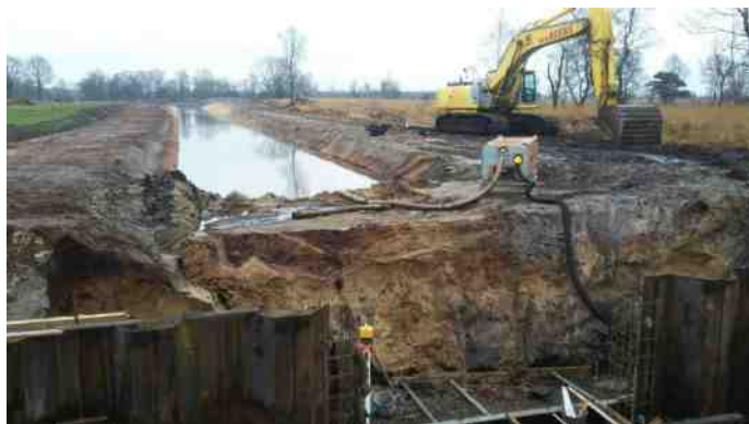
Aanleg nieuwe stuw
