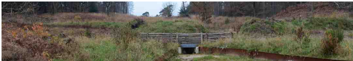
De reptielen-, ook wel addertunnel bij Vlodrop-Station, foto Joost Geraets
