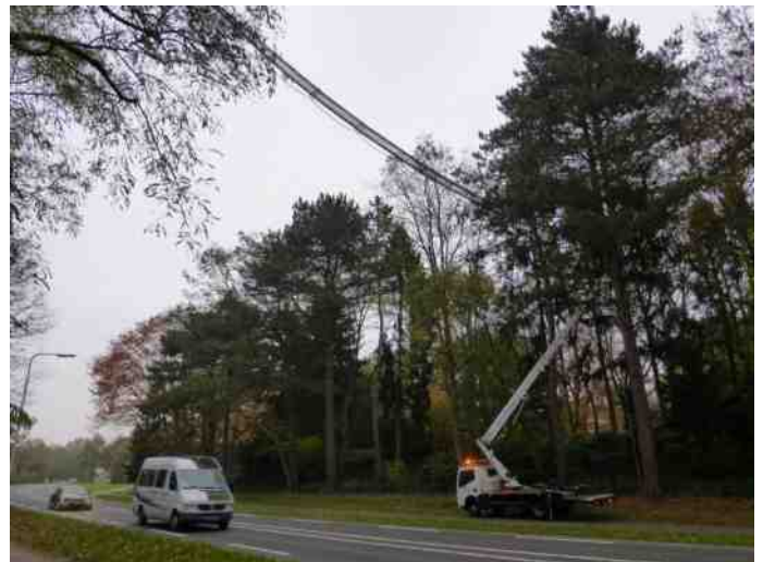
Installatie Eekhoornbrug, foto Steven Jansen
