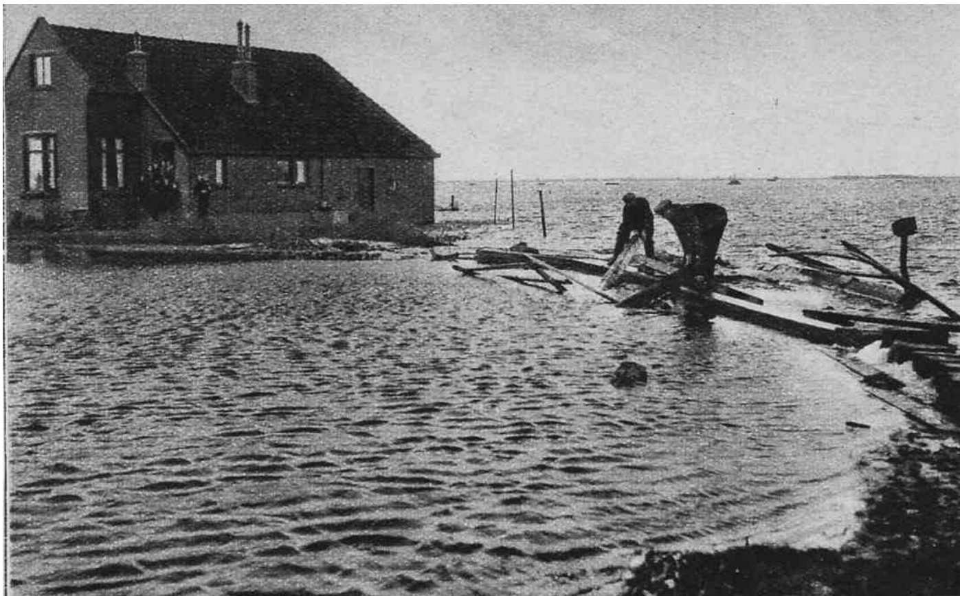
Aanleggen van zogenaamde noodwegen naar de huizen in de ondergelopen Peizermaden (1932), met oud hout en dergelijke. Alles voor de bereikbaarheid! Foto uit archief K.A. Hagenouw, gepubliceerd in het blad: Het Noorden in Woord en Beeld. Het huis betreft Groningerweg nummer 45.
