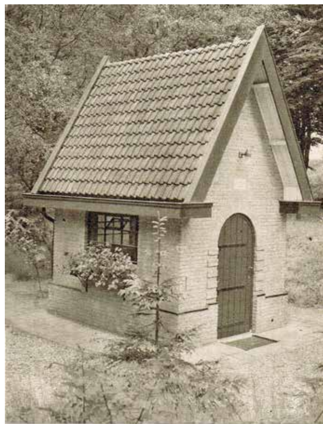
Een opname van het afzonderlijke gebouwtje waarin zich de diepveelinstallatie met verticale electromotor van 30 P.K. bevindt. De diepte van de put bedraagt 135 meter.
