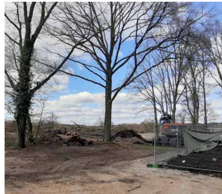
Aanleg natuurspeelplaats bij Rheden (april 2020)
