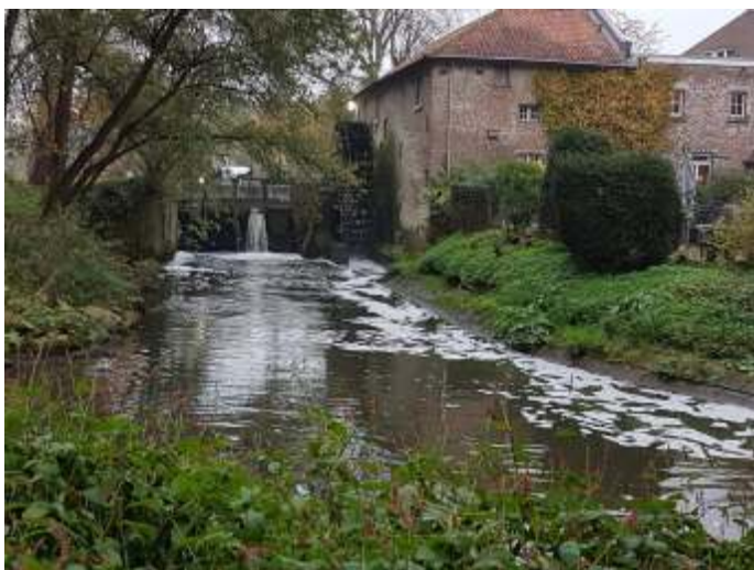
De Ophovenermolen in Sittard als vismigratieknelpunt in de Geleenbeek, de situatie in 2017. Vissen waren niet in staat om de molenstuw te passeren. Foto Ben Crombaghs
