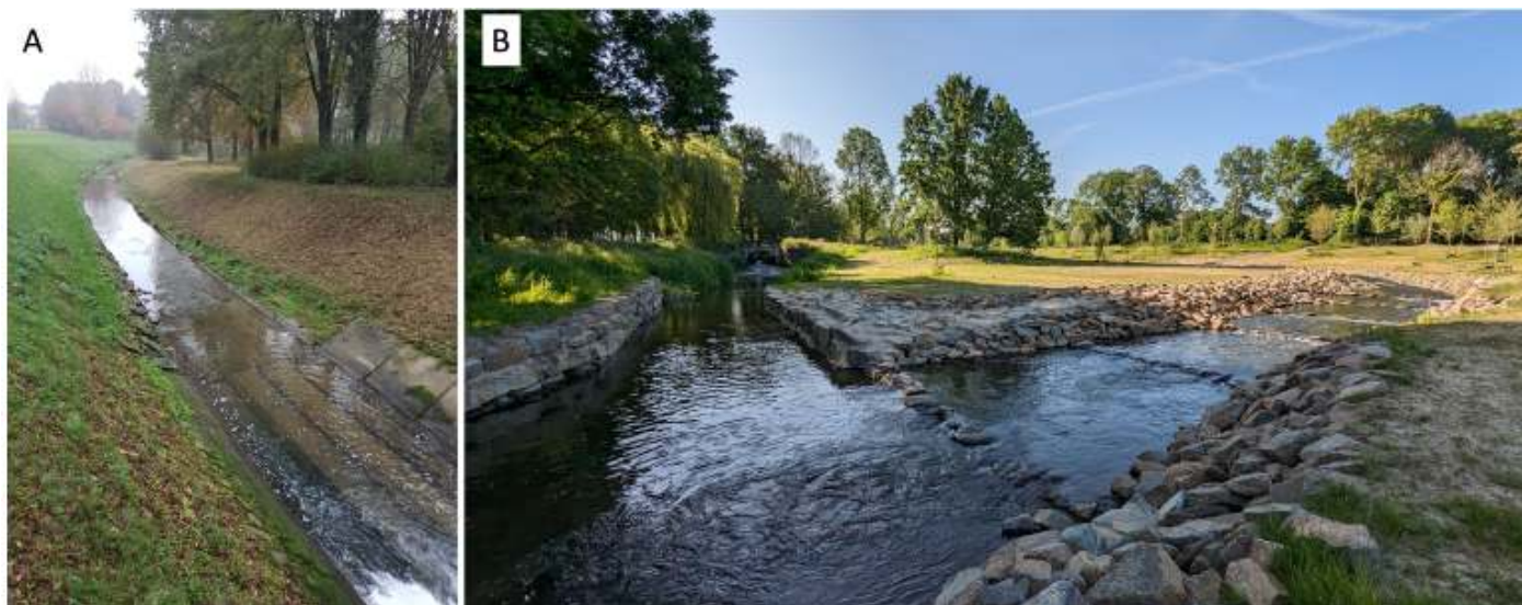
(A) De situatie van de Geleenbeek stroomafwaarts van de Ophovenermolen in Sittard voor het beekherstel in november 2017. (B) De situatie na de beekherstelmaatregelen in 2023 waarbij het snelstromende karakter is hersteld. Foto's Ben Crombaghs & Pim Lemmers
