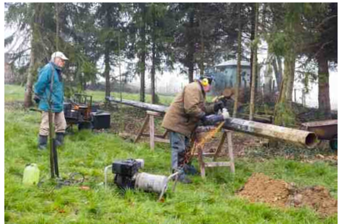
Eerst wordt de paal ingekort.
