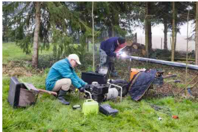
De nieuwe kast wordt met beugels aan de paal gelast; Het aggregaat moet een beetje geholpen worden.
