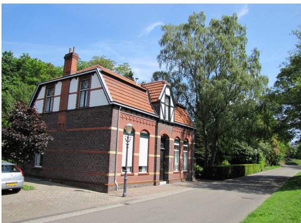
karakteristiek huis met mansardedak
