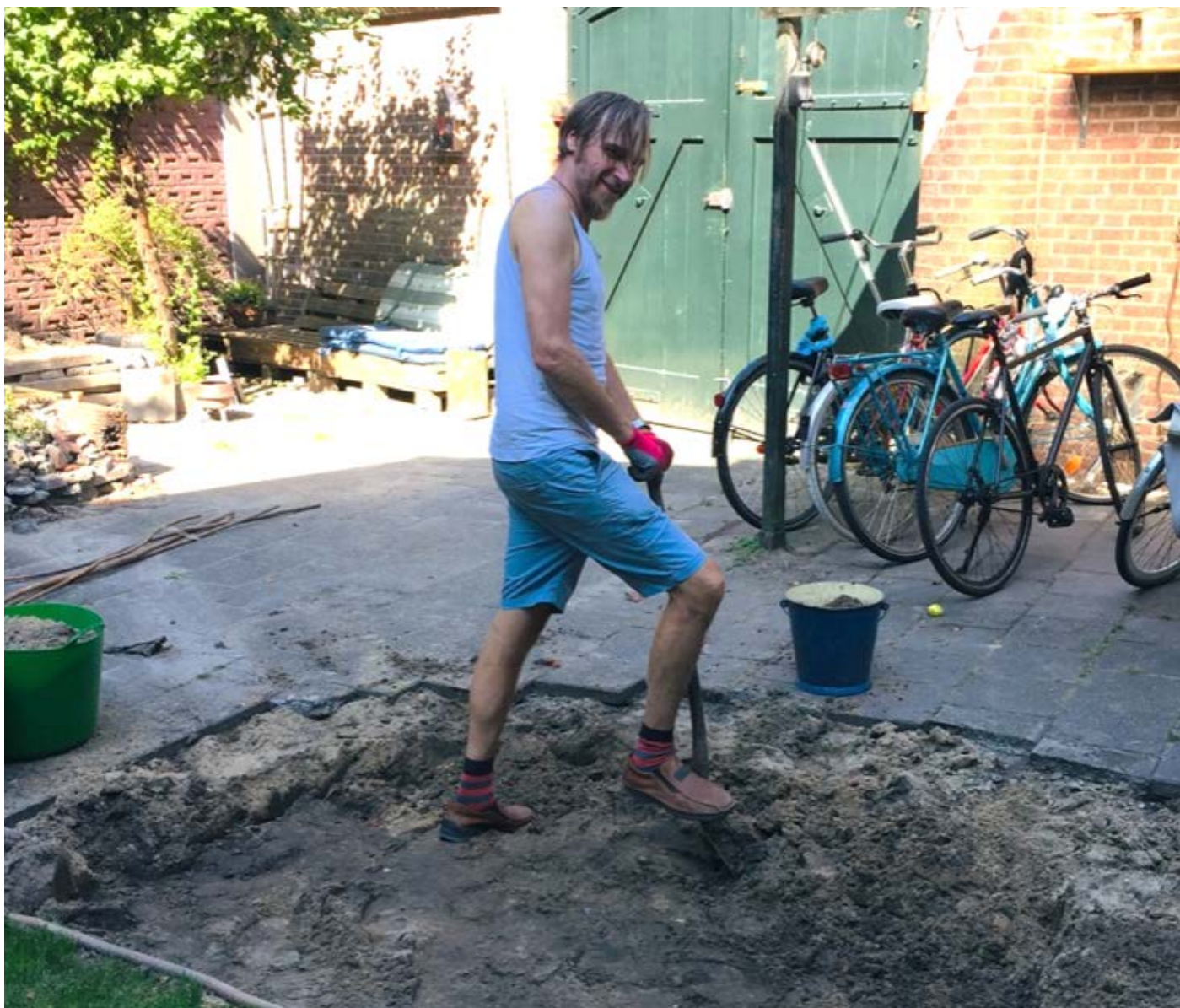
Tegels eruit, spade erin! Graafwerkzaamheden prototype Utrecht.
