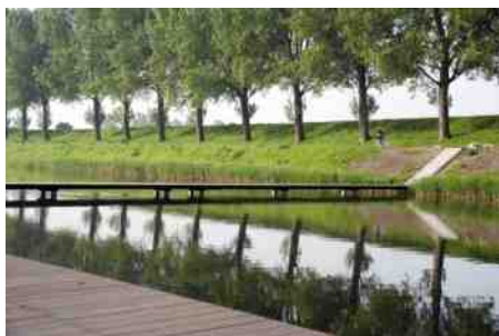
Voetgangersbrug naar de Geniedijk
