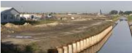
Werkzaamheden zijn in volle gang.
