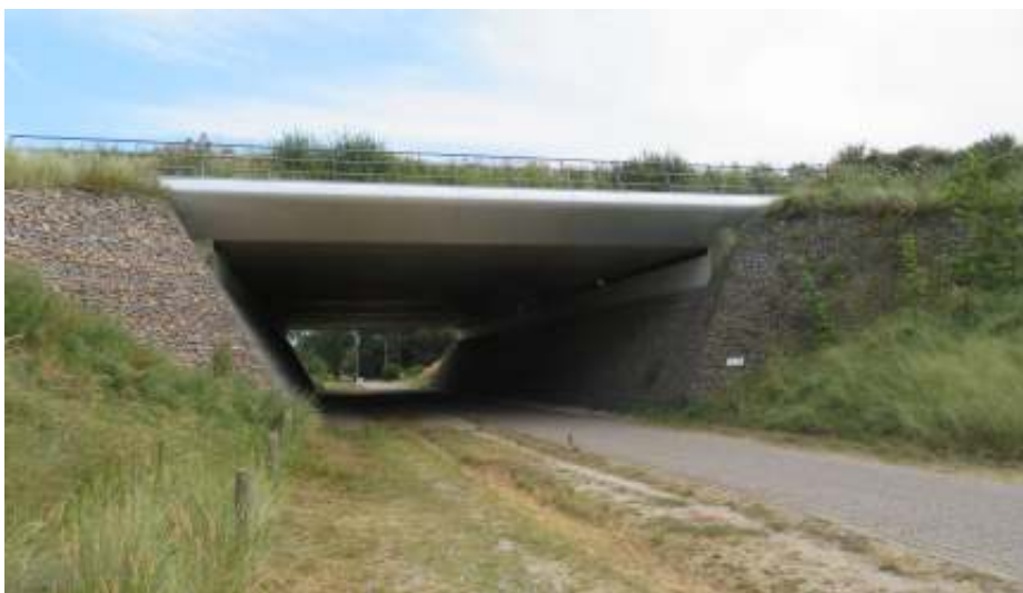
Ecoduct de Zandpoort.
