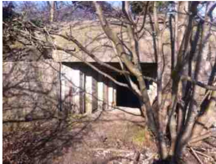
Bunker en stuk Atlantikwall.
