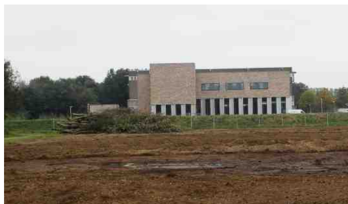
het begin van de aanleg van de hoogte verschillen op het perceel met op de voorgrond een van de twee laagtes waar zich al wat water begon te verzamelen.
