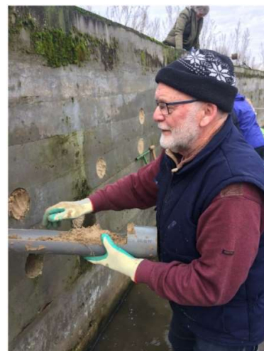
Werk aan de oeverzwaluwwand
