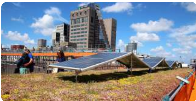
Lichtgewicht zonnepanelen / recycled plastic / rooftopwalk.nl/6 foto: T. Wouda
