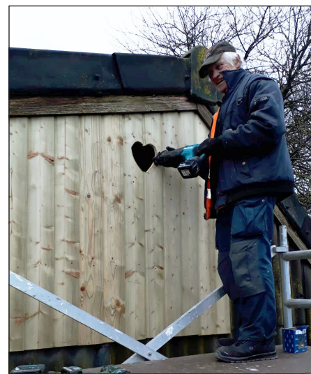
Alof zaagt een keurig vlieggat in de nieuwe schuurwand
