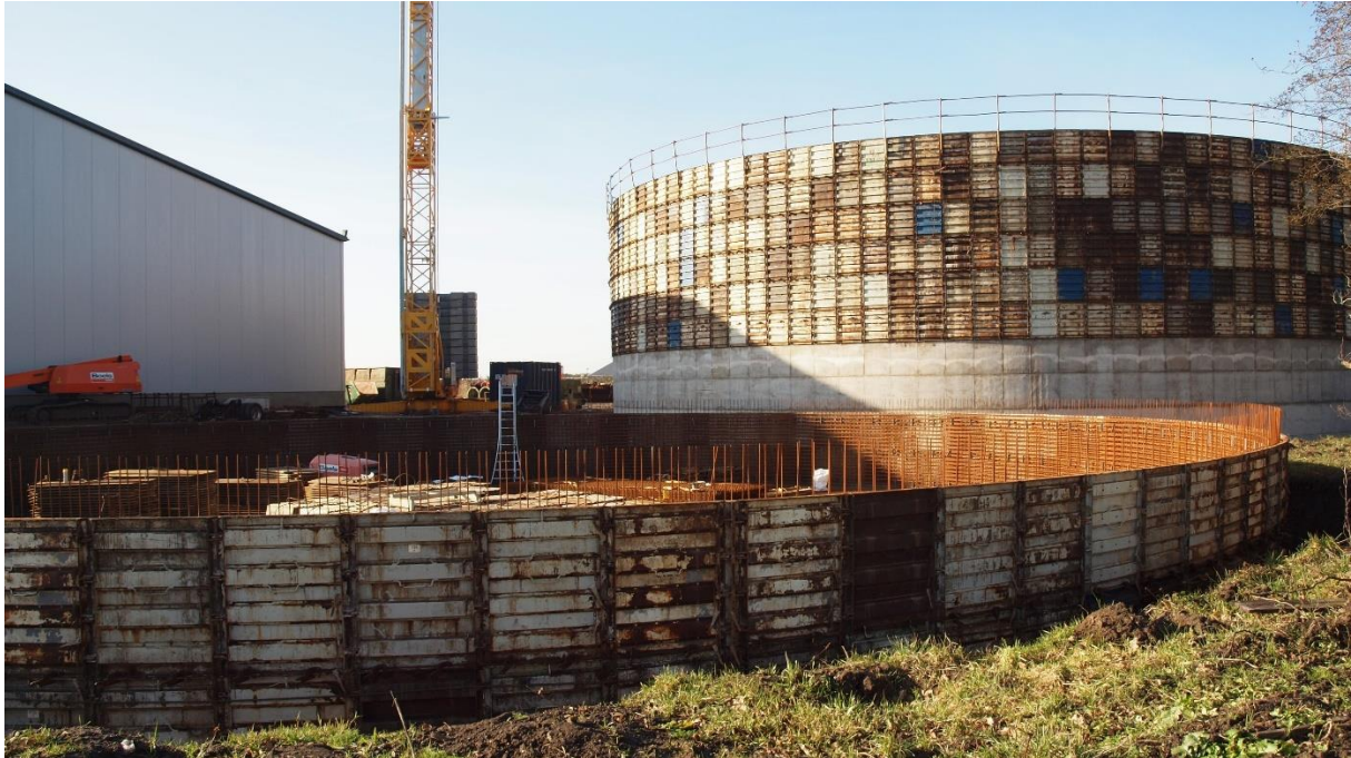
Mestvergister Cothen in aanbouw, foto eind januari 2024
