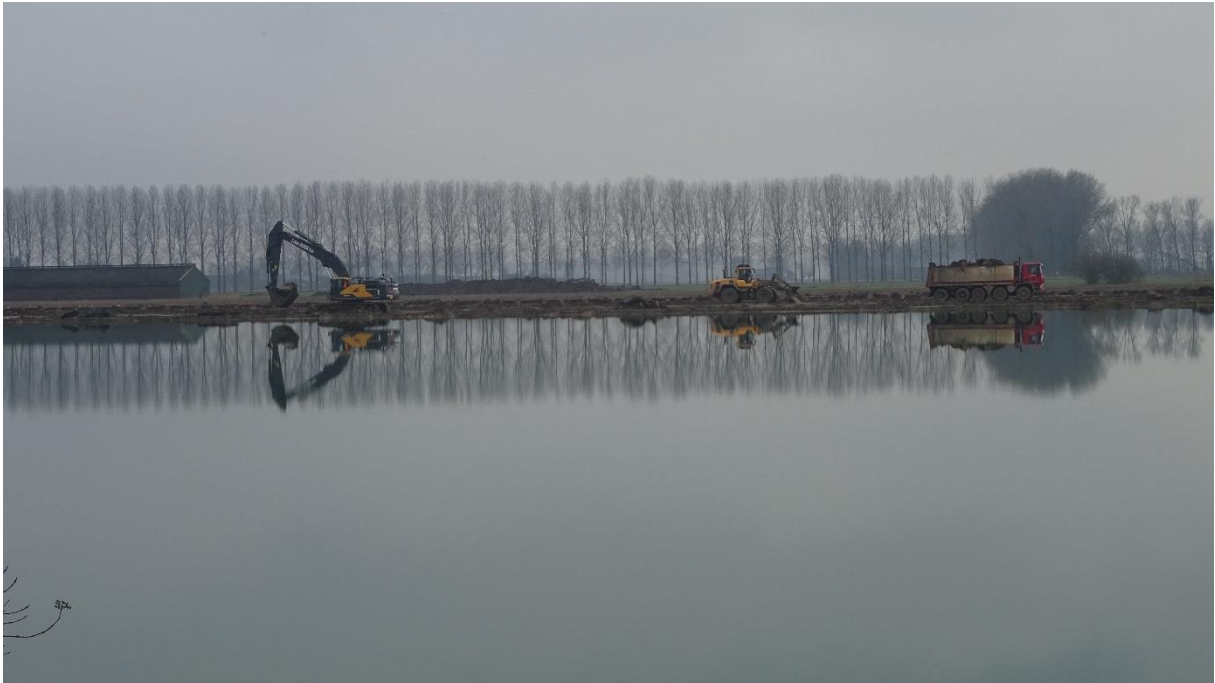
Afgraven van de kleilaag in het project Geertjesgolf
