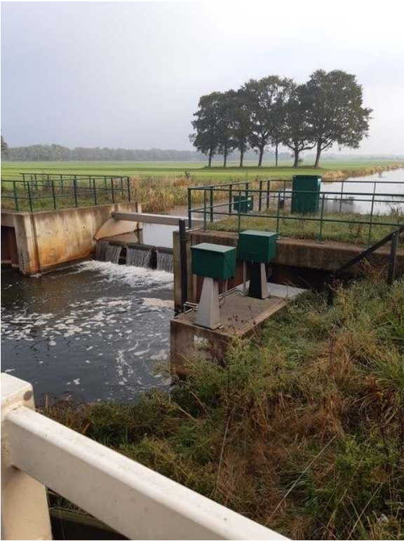
De vissluis aan de Helomaweg, foto Frans van Lieshout
