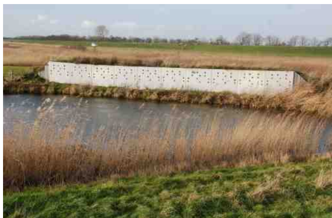
Oeverwaluwand bij waterberging Twisk
