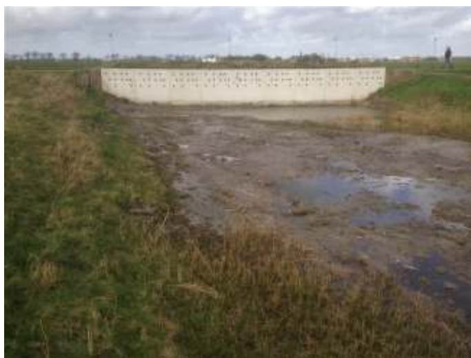
De grond voor de wand is uitgediept.
