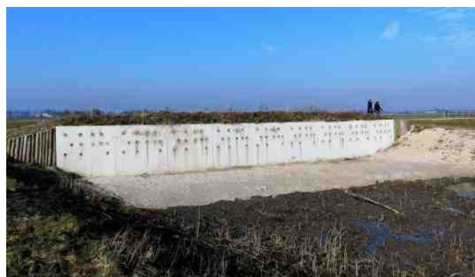
Het zandbed is aangepast
