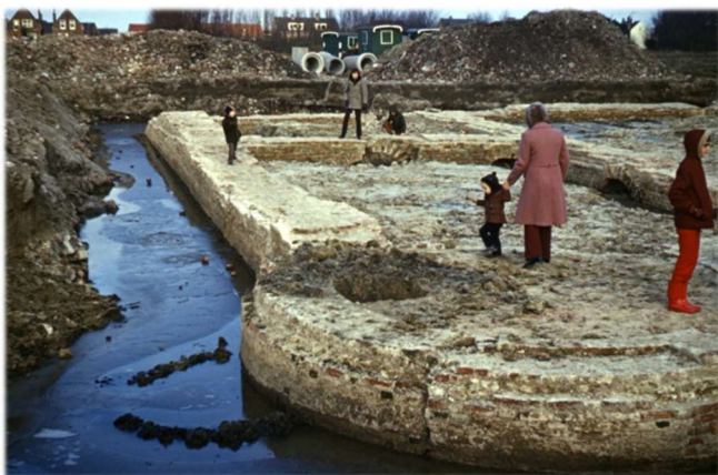
Opravingen van de fundamenteën van Kasteel Aldegond begin jaren '70 vanwege bouw Westerzicht (Zeeuws Archief, fotocollectie Vlissingen, nr. 50806)
