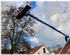
Met hoogwerker nest verwijderen
