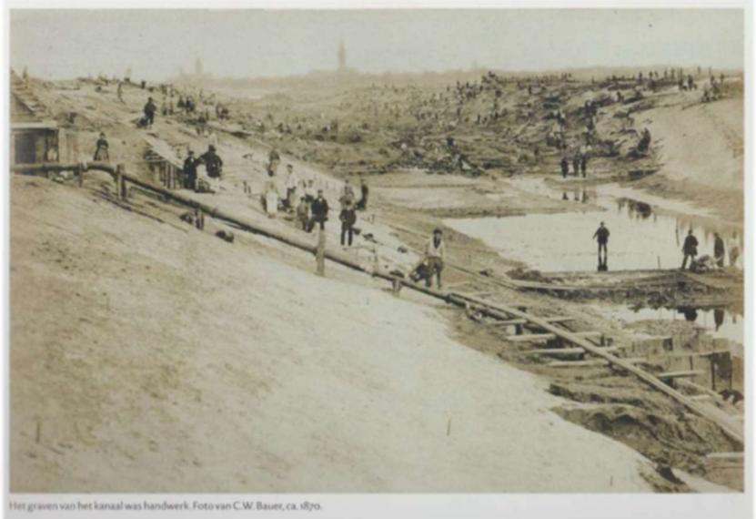
Het graven van het kanaal was handwerk (Zeeuws Archief)
