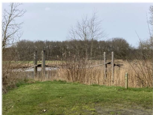
Over de touwbrug in het Veerse Bos
