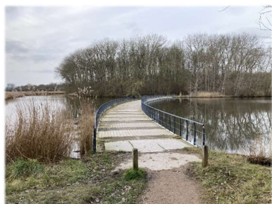
‘De waterbrug’ in de Veerse Kreek
