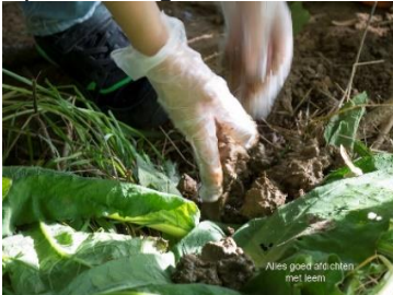
Alles goed afdichten met leem
