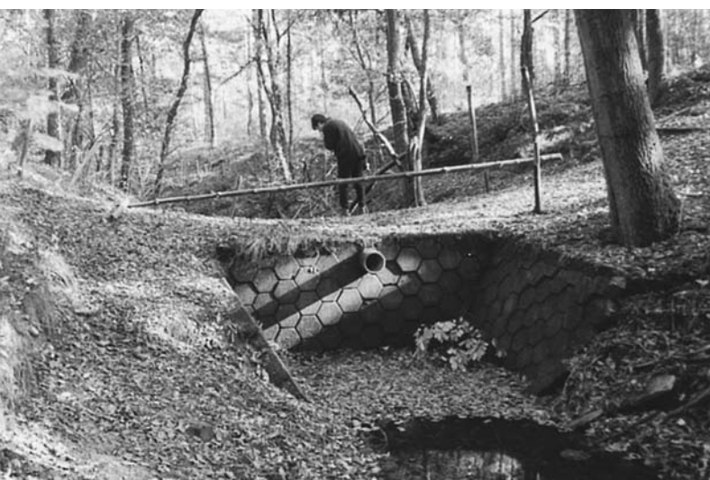
Deze foto genomen omstreeks de eeuwwisseling laat de dam zien vanaf de sprengenkoppen.
