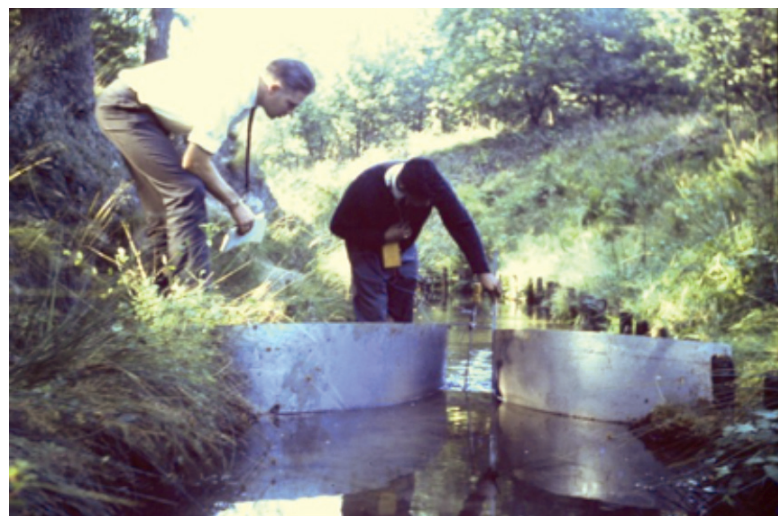
Het aanleggen van de dam.
