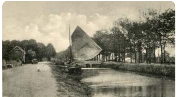
Eerbeek Links de brugwachterswoning Apeldoornseweg 11 bij de Eerbeeksebrug. Rechts de loodsen van de daar (Voortvondensmet 34) gevestigde boomkwekerijhandel, toen Boezewinkel, later Brouwer en nu (2018) Nobel. De loodsen waar het schip voor ligt is in 1809 in gebruik genomen, postkaart 21 augustus 1934
