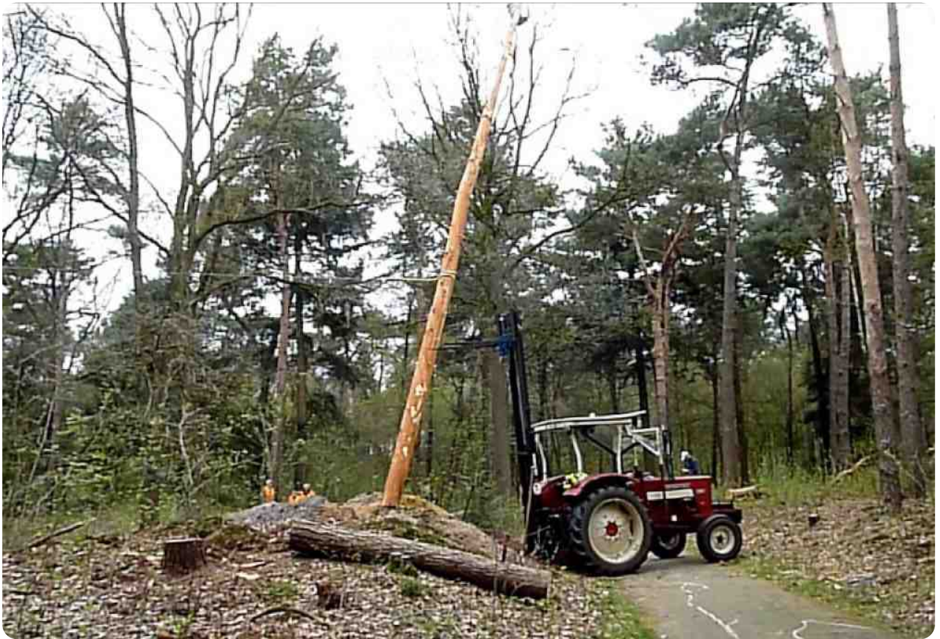
Het plaatsen van een "Lange Juffer"
