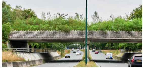
Ecoduct over de N237 bij Soesterberg.
