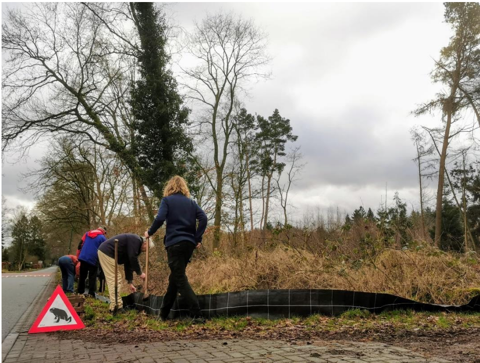
Plaatsing van een paddenscherm aan de Wieksloterweg. Foto Ton Paauw
