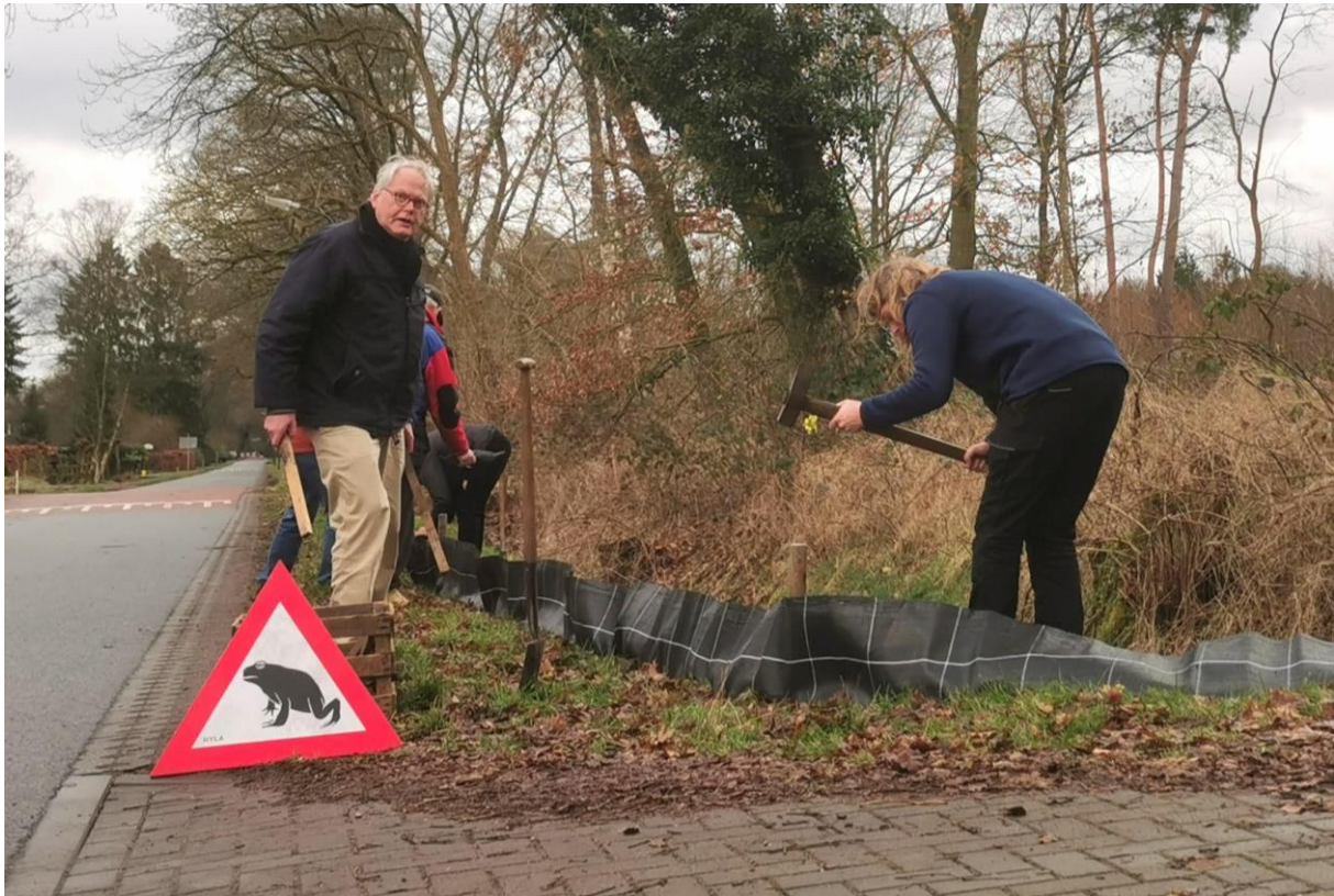
Tim de Wolf (links) bij het plaatsen van schermen. Foto Ton Paauw
